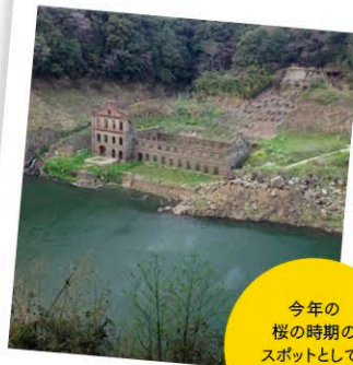
旧曾木発電所遺構
